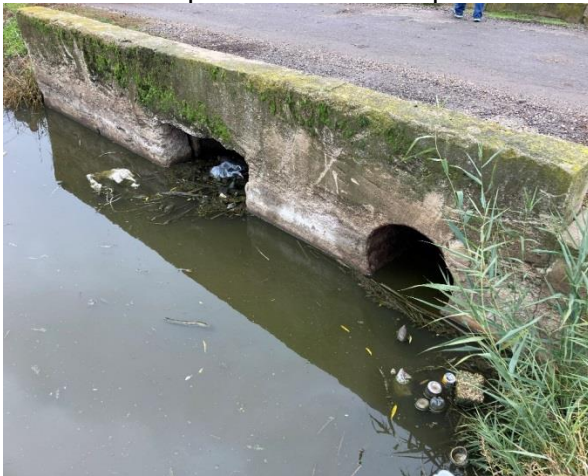
Foto 1.3.1.10. Pârâu Slătioarele - podețe existente pe str. Aviator Petre Oanta
