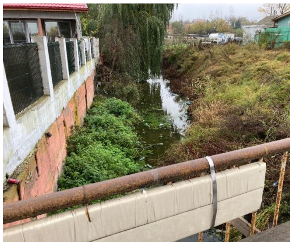
Foto 1.3.1.15. Pârâu Slătioarele -vedere amonte de podeț de pe DJ503
