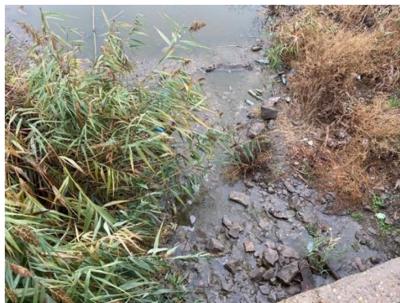
Foto 1.3.1.2. Râu Câlniștea - zona aval de podul de pe DN6 (E70) (imediat sub pod)
