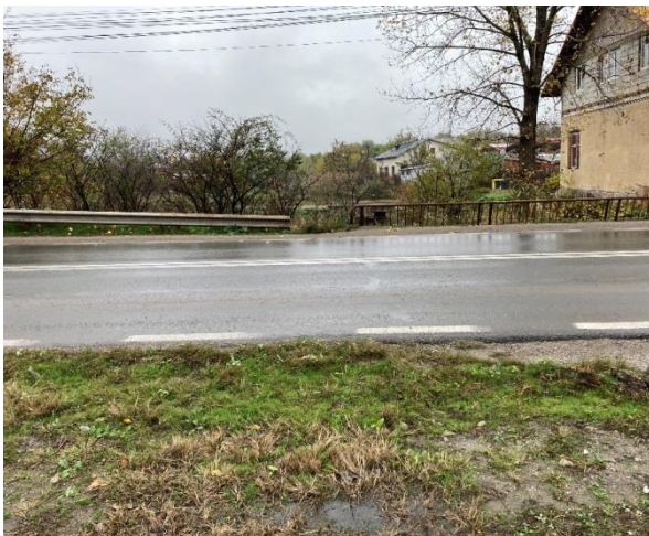
Foto 1.3.1.12. Pârâul Slătioarele - vedere spre amonte de podețul boltit pe DN6
