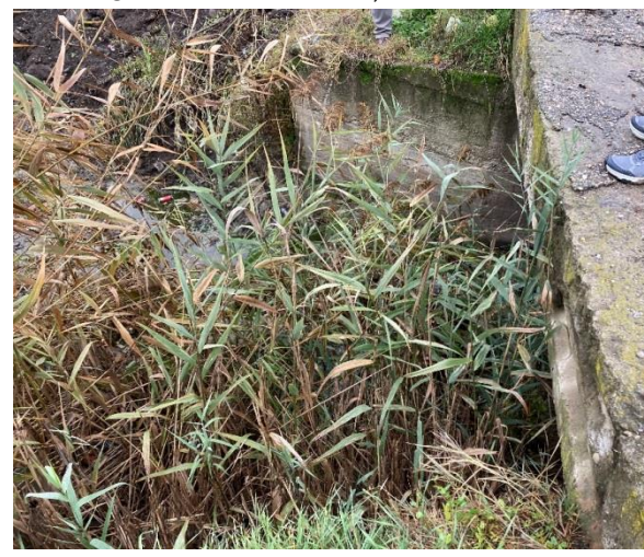
Foto 17. Pârâu Slătioarele – podeț existent pe DJ503
