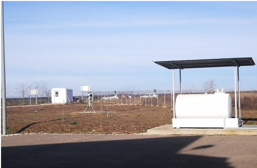
Foto 5 Clădire poarta, stația meteo, rezervor de motorină pentru generatorul electric
