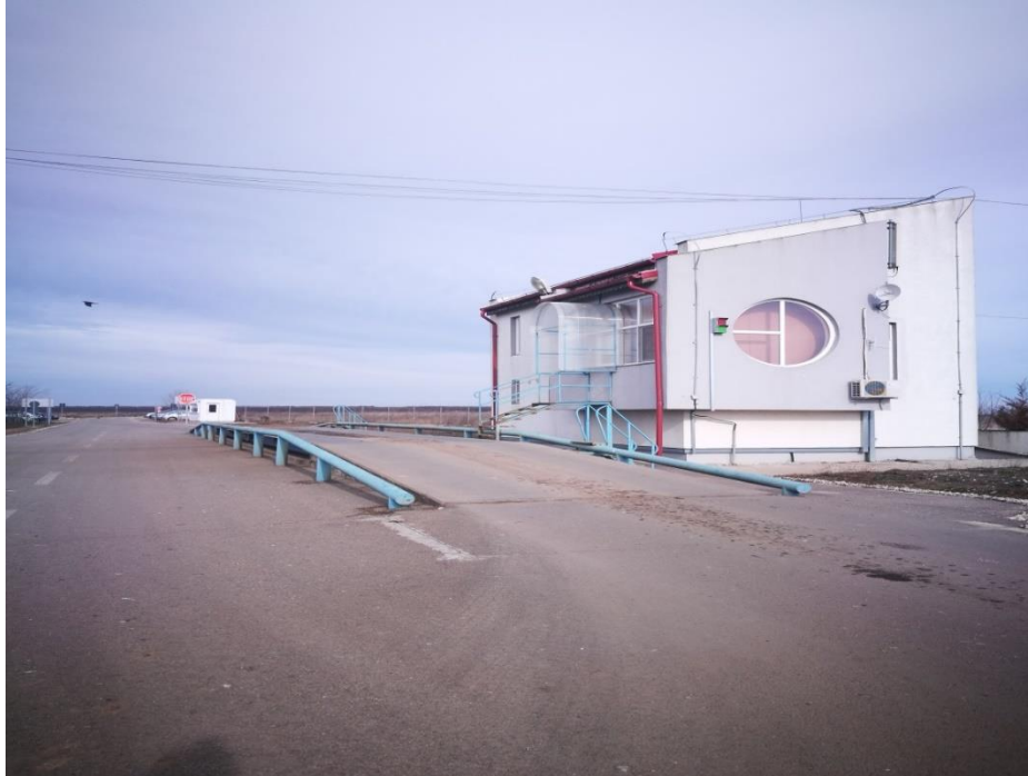
Foto 6 Clădire poartă, cântar, clădire administrativă
