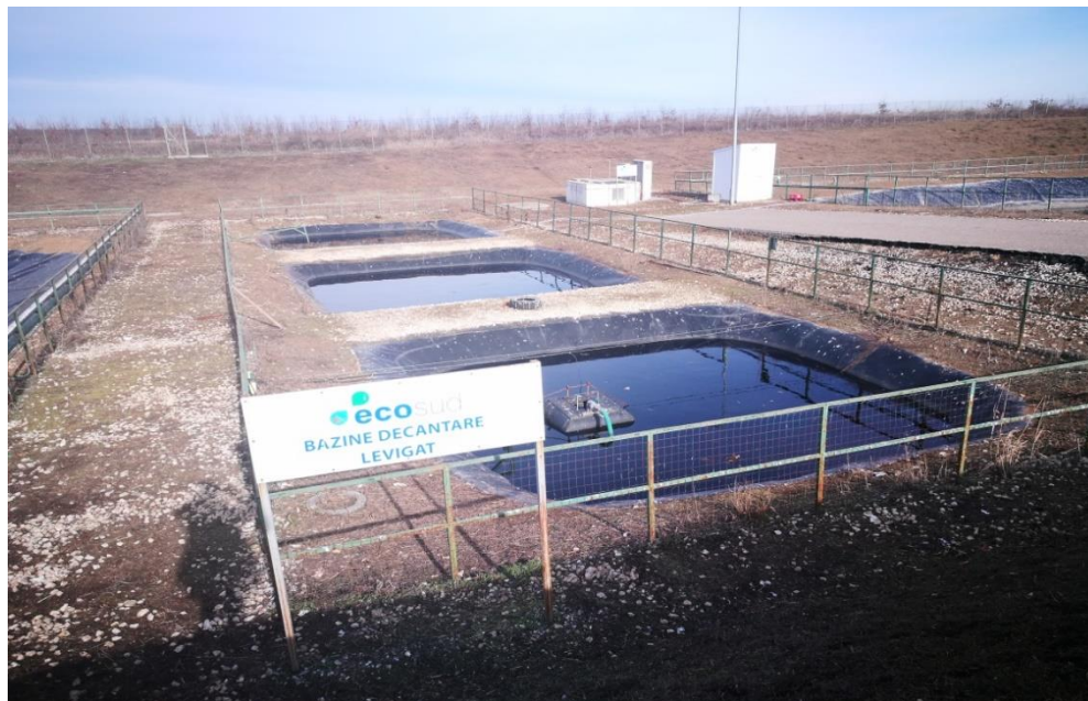
Foto 24 Cele trei bazine de decantare levigat
