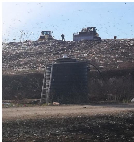
Foto 16 Celula 1 de depozitare a deșeurilor și un cămin de colectare levigat
