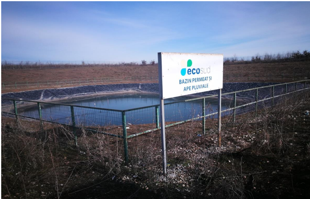
Foto 26 Bazin de retenție permeat și apele pluviale conventional curate
