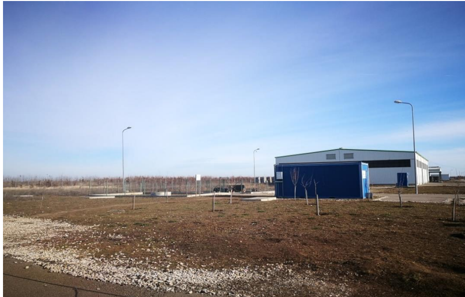
Foto 14 Puțul de alimentare cu apă, stația de clorinare și atelierul mecanic/garaj
