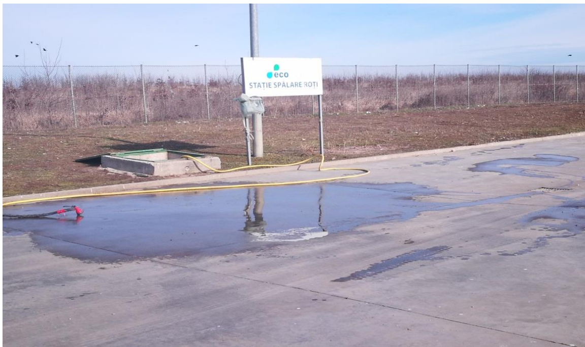
Foto 2 Stația/platforma de spălare auto
