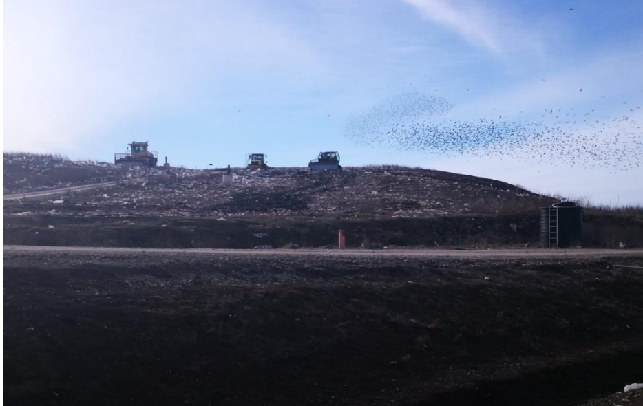
Foto 15 Celula de depozitare a deșeurilor (cu utilajele în funcțiune și stoluri de păsări-ciori)
