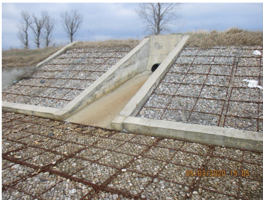
Foto 22 Evacuare ape uzate epurate în Pârâul Câinelui
