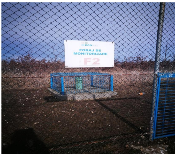
Foto 29 Puț de observație a calității apei subterane
