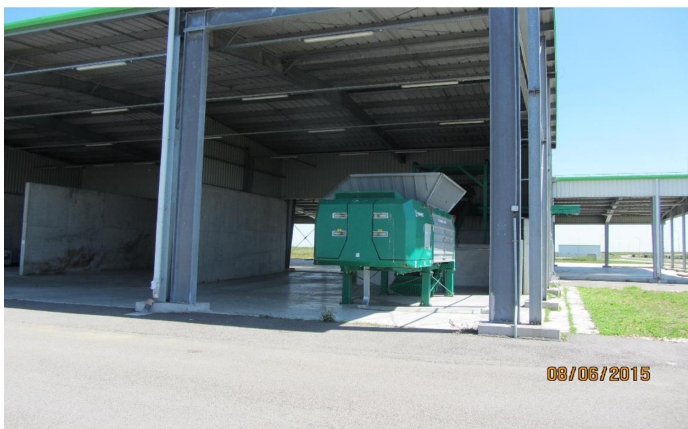
Statia de compostare SC ECO SUD SRL Bucuresti- Depozit Mavrodin
