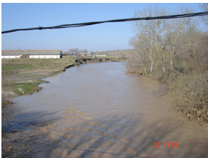
FOTO 6: Lunca pârâului Câinelui amonte de podul rutier de pe DJ 703 (zona A1)
