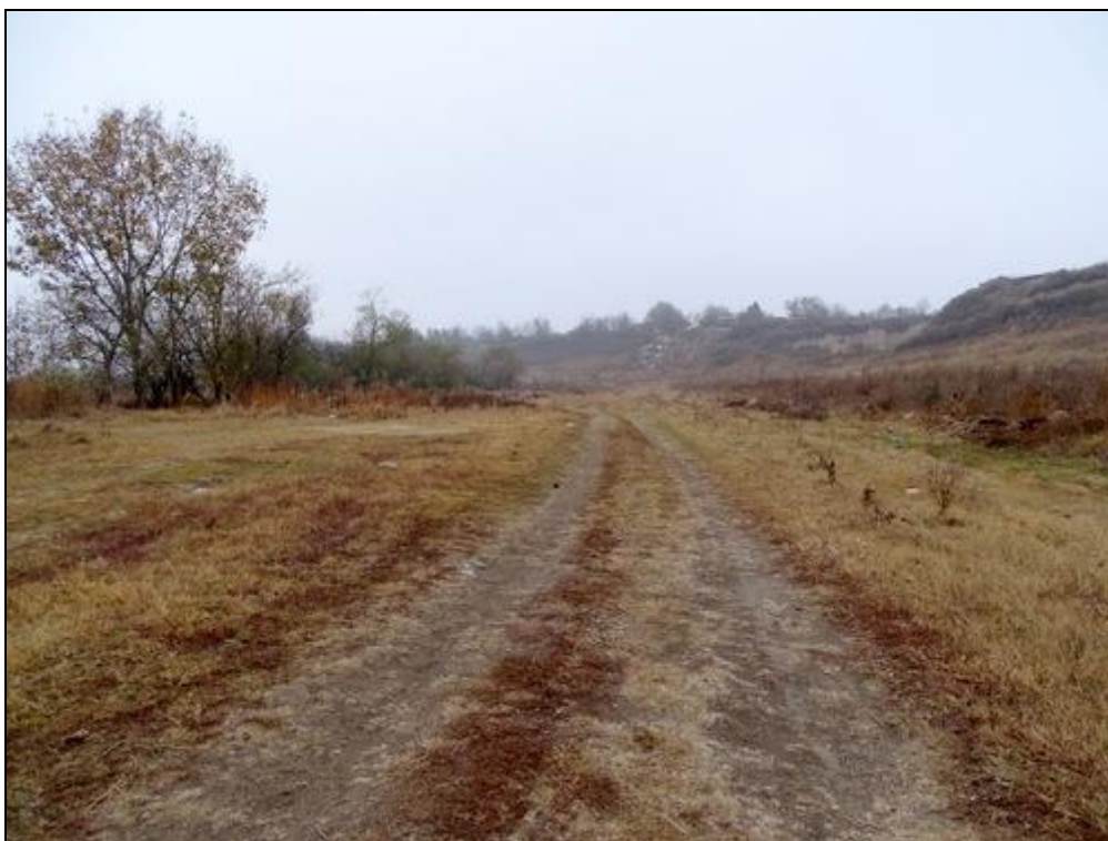
Figura nr. 39 – Aspect privind traseu de pozare a conductei de canalizare și de distribuție apă potabilă din zona nordică a intersecției amplasamentelor cu ROSCI0376 Râul Olt între Mărunței și Turnu Măgurele
