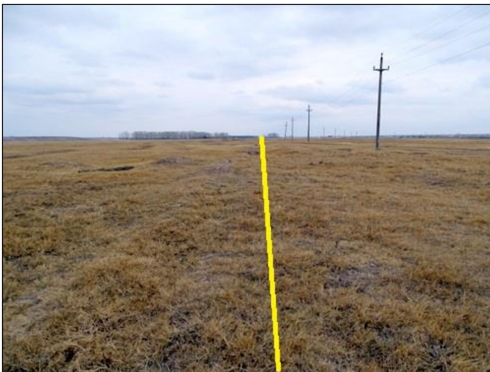
Figura nr. 26 – Aspect privind tronsonul de inlocuire conductă legătură puțuri între puțul nr. 21 și puțul nr. 20
