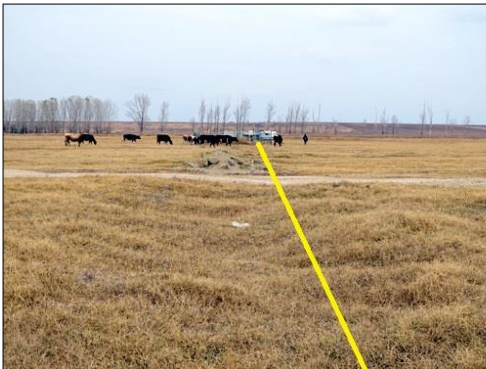
Figura nr. 29 – Aspect privind tronsonul de înlocuire conductă legătură puțurile nr. 18' și 18"
