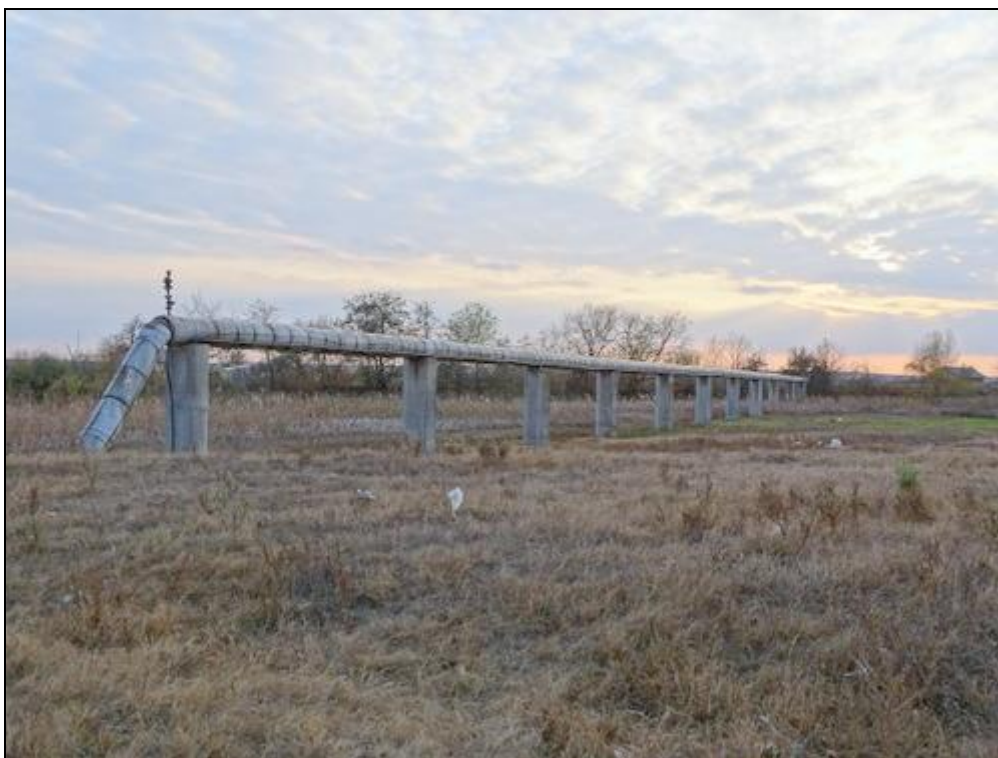
Figura nr. 20 – Aspect privind traversarea conductei de legătură între puțurile 34 și 33 pe o estacadă, deasupra cursului de apă Barăcea
