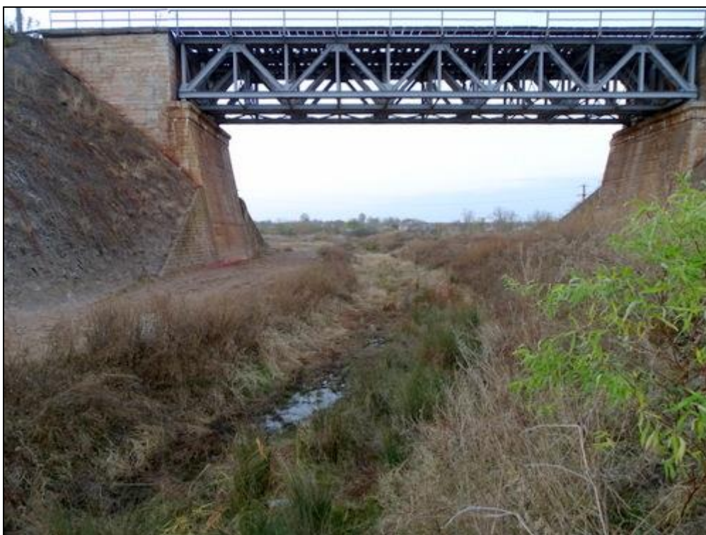
Figura nr. 16 – Aspect privind starea ecologică a pârâului Bratcov în sectorul vizat de realizarea unei subtraversări a unei conducte de aducțiune
