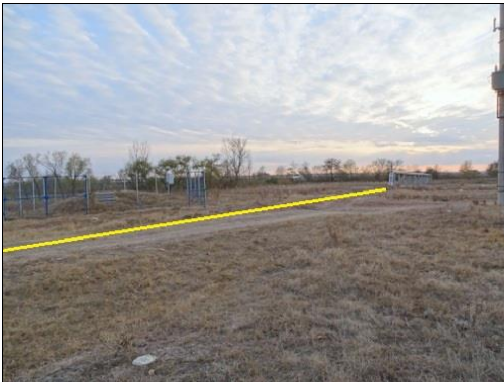
Figura nr. 22 – Tronsonul de conductă cuprins între estacada de pe cursul Barâcea și puțul nr. 33
